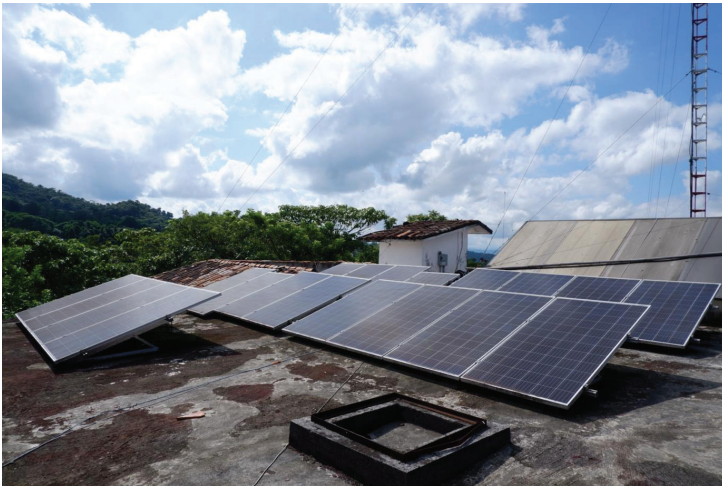
Figura 3. Sistema autónomo de nueve células fotovoltaicas en el techo del Kaltaixpetaniloyan de Tosepan. Fotografía de los autores.
